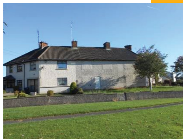
Bothar Brugha Roimh Ré
